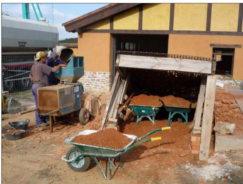
Fig. 1.- Vista del proceso de preparación de la tierra: Criba y Pulverizadora
